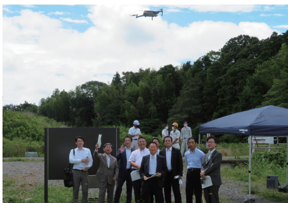
高性能ドローン導入による土木工事
