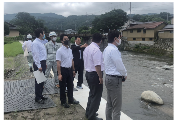
台風19号での河川氾濫の復旧工事
